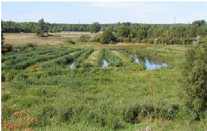
Översilningsyta och damm vid Hagbytippen, Täby kommun (SÖRAB).
